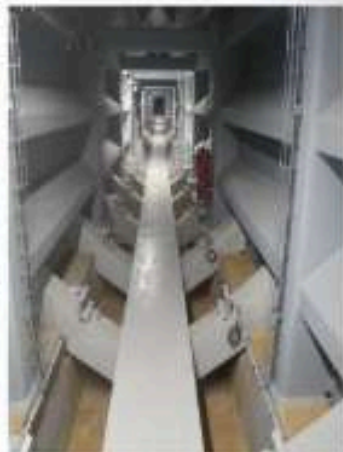
→ La vidange gravitaire des cellules est assurée par des trémies en pente de 4° ou 8°.
