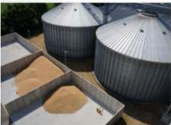
→ Des stockages extérieurs sont ménagés et utilisés en cas d'encombrement des fosses de déchargement.
