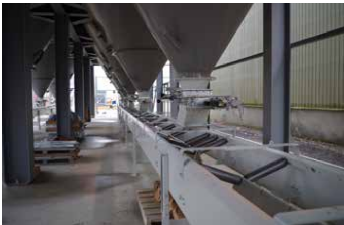
→ Transporteurs 20 t/h en cours de montage.
